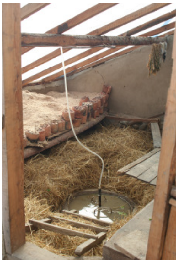
Haushalts-Biogasanlage Nordkorea. (Foto: Welthungerhilfe)
